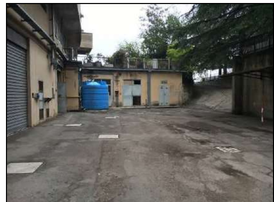
Vista esterna seminterrato
