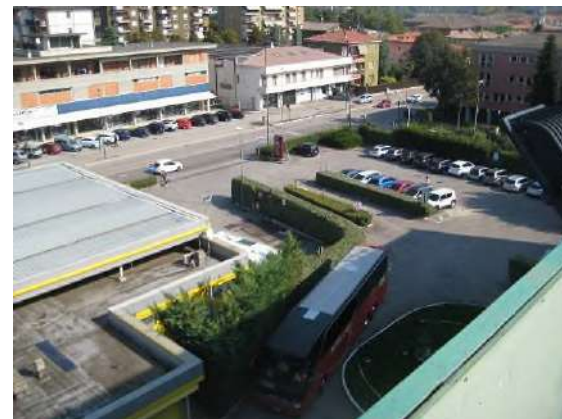
Vista area esterna ingresso
