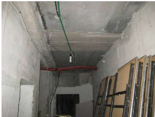
Locali al grezzo (primo interrato)
