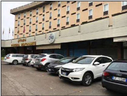
Vista esterna – Ingresso CNA e ristorante
