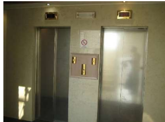
Ascensori al piano primo
