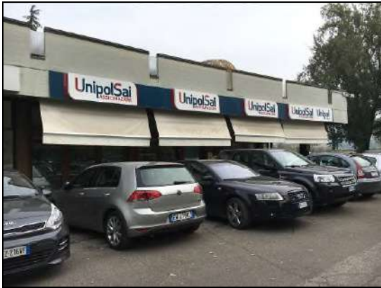
Vista esterna–Filiale bancaria/assicurazioni
