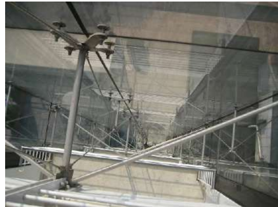
Particolare vetrata vano scale
