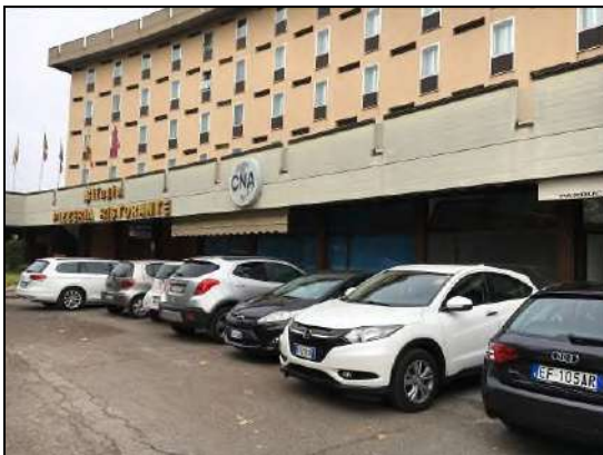
Vista esterna – Ingresso CNA e ristorante
