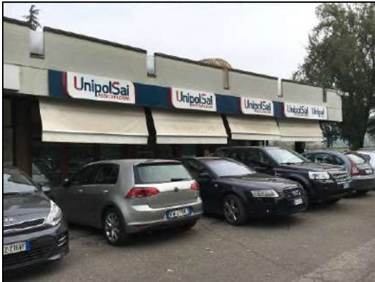
Vista esterna–Filiale bancaria/assicurazioni
