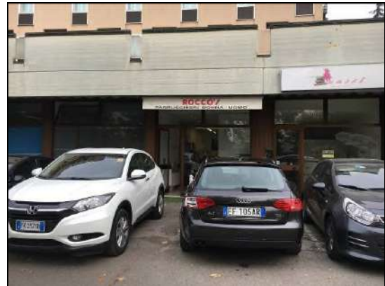
Vista esterna–Locali sfitti e parrucchiere
