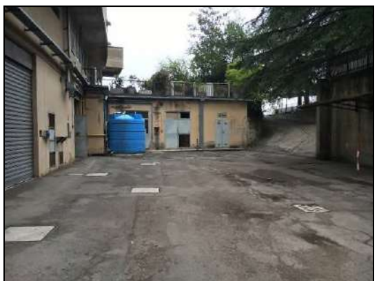
Vista esterna seminterrato
